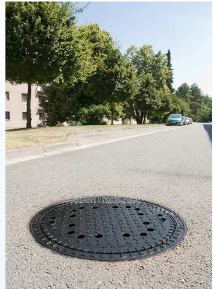
Obr. Poklop D400 v komunikaci na hlavní kanalizační stoce
