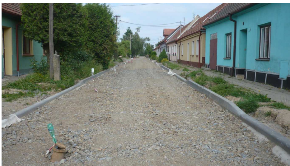
Na komunikaci navezený odval 0-63...
